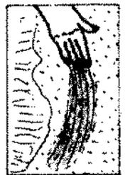
Cet enduit à l'état de boue souple et plastique va recouvrir entièrement le mur de banco.
